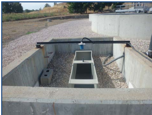
Arqueta de salida y medición de caudal
